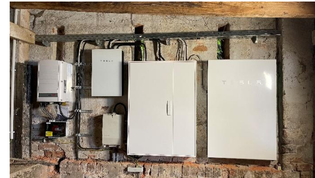
Elektroinstallation und Batteriespeicher PV-Anlage Arensnest
